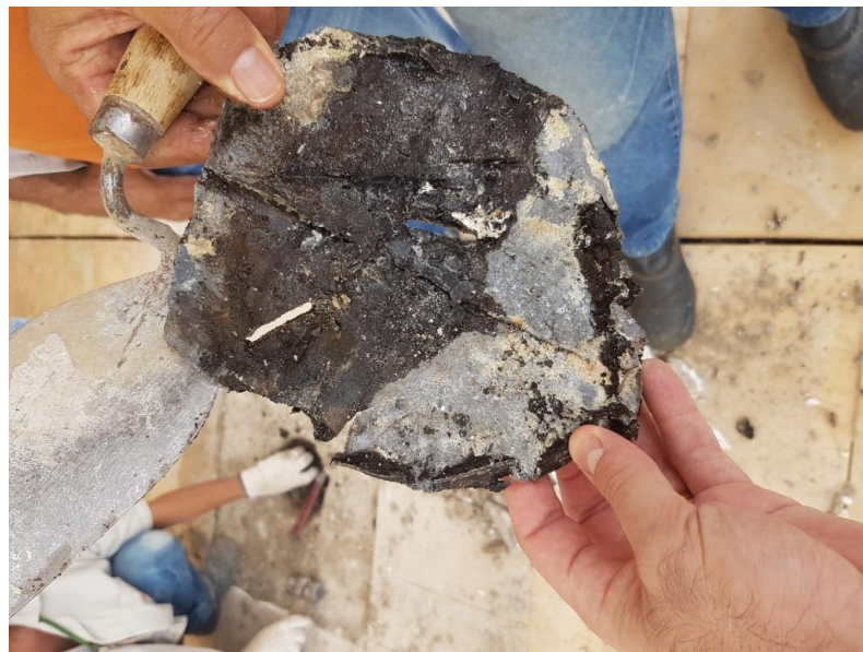
Figura 05: Impermeabilização original do Edifício Principal.
